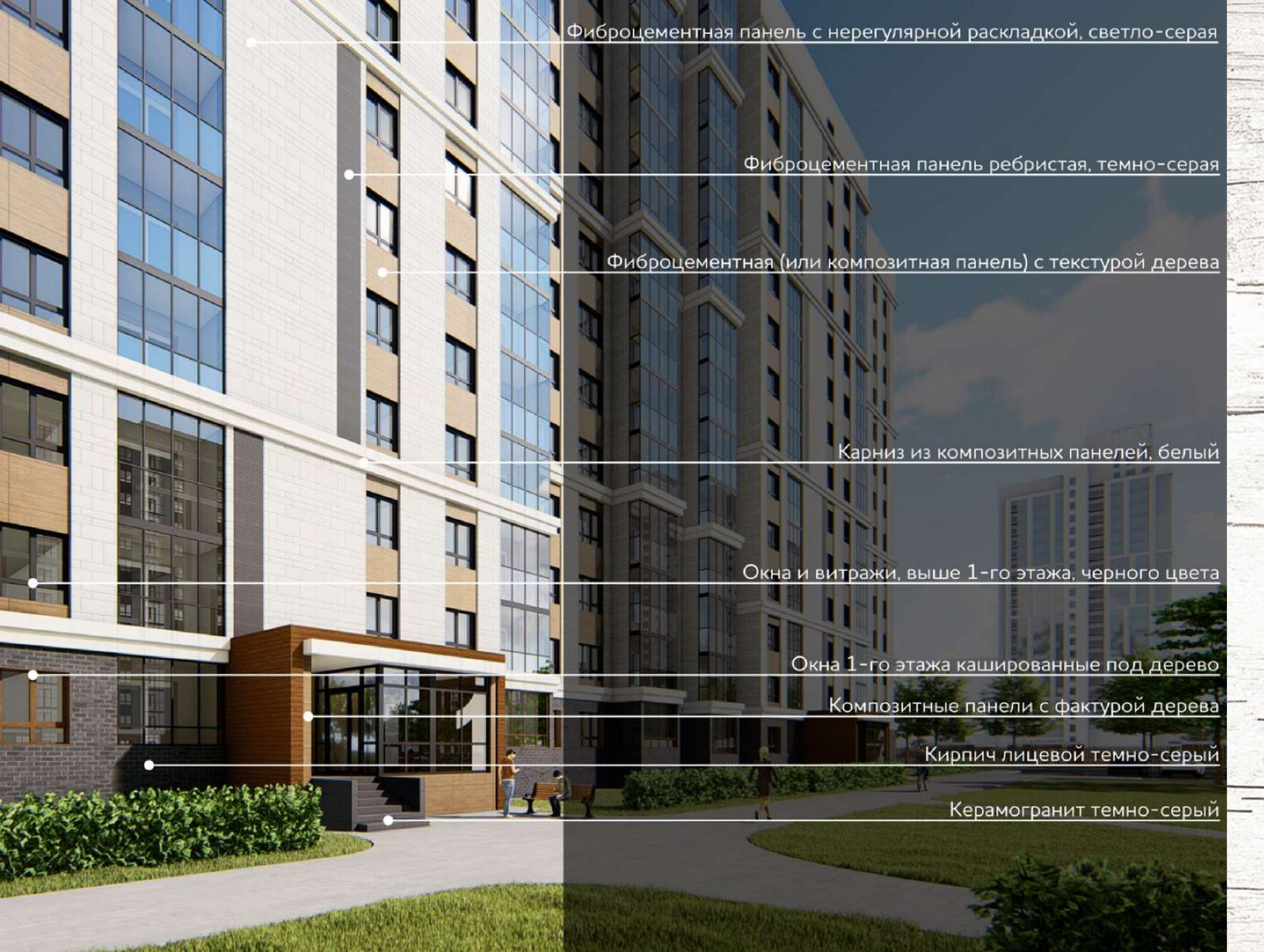
Фиброцементная панель с нерегулярной раскладкой, светло-серая
